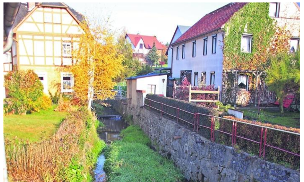
Wohngebäude, wie hier in Schlegel am Kemmlitzbach, besitzen Bestandsschutz. Ein Rückbau der Ufermauern würde unweigerlich zum Verlust der Standsicherheit der Gebäude führen. In diesem Rahmen ist ein Unterhalt der Ufermauern zwingend notwendig.
